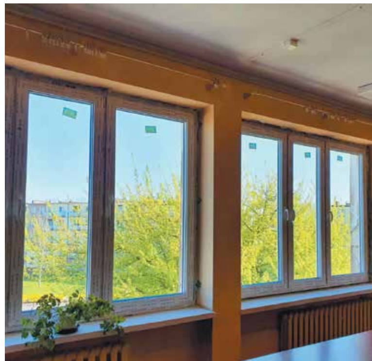
W budynku zostały już wymienione okna
