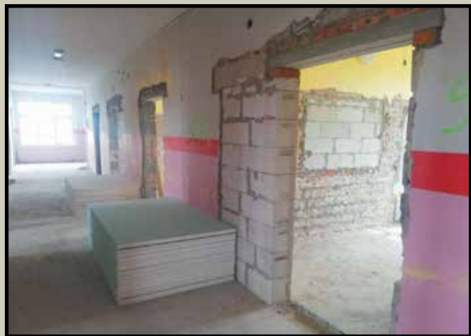
Wydzielanie pomieszczeń pod oddział dziecięcy
