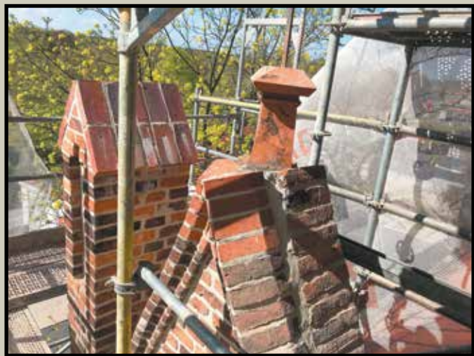
Kontynuacja prac przy attyce
