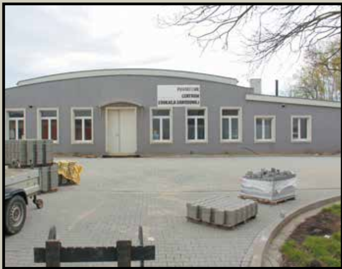
Utwardzenie terenu wokół budynku
