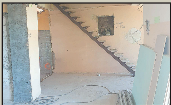
Przygotowania do podwieszenia sufitów
