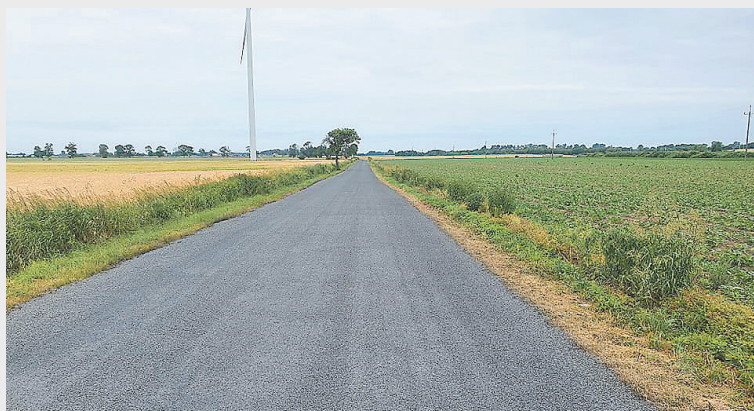
Wyremontowany odcinek drogi w Gąsiorowie
