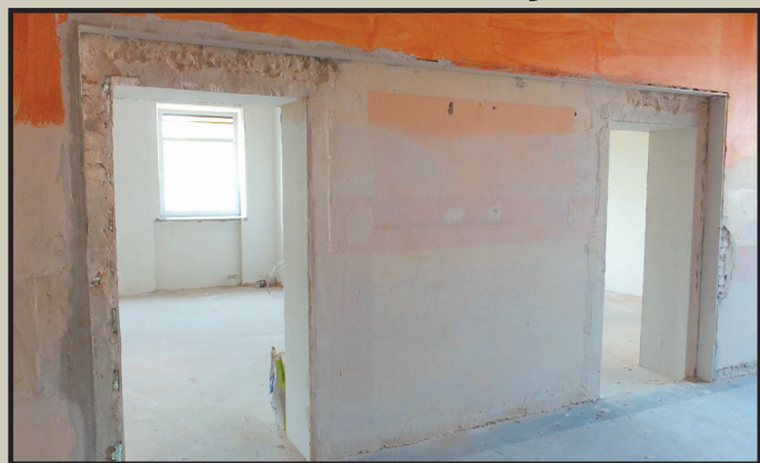
Kontynuacja prac budowlanych
