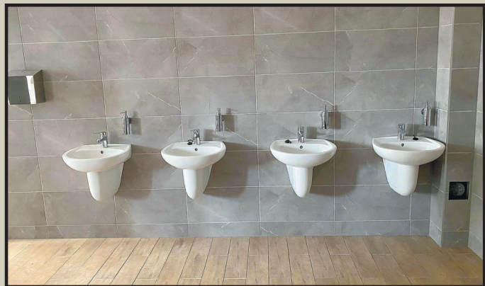
Prace wykończeniowe glazury łazienkowej
