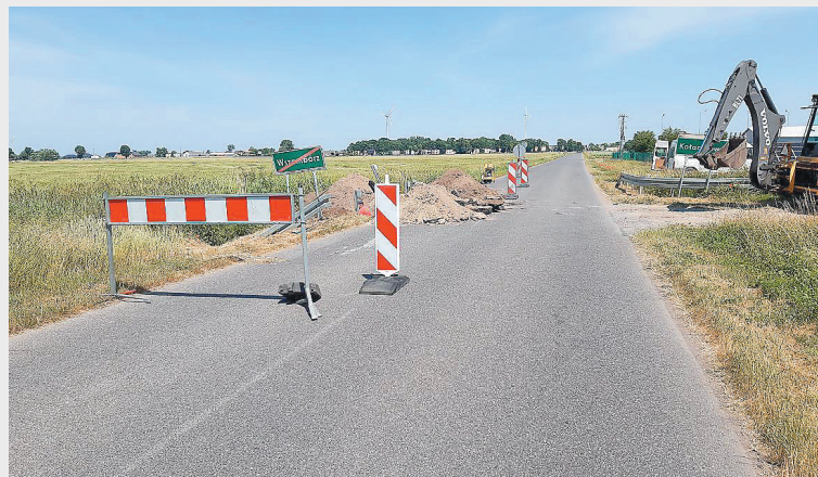
Naprawa przepustu pomiędzy Kołaczkowem a Wszemborzem
