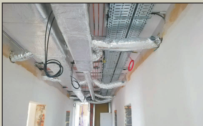
Na półmetku inwestycji montowana jest instalacja
