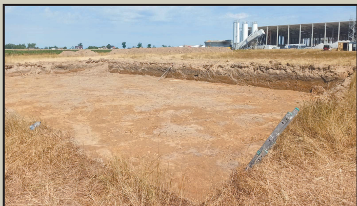
Pierwsze prace związane z wykonywaniem fundamentów
