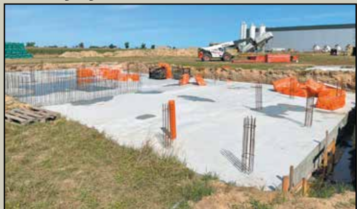
Betonowanie płyty fundamentowej
