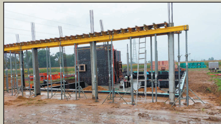
Konstrukcje żelbetowe związane z budową parteru budynku
