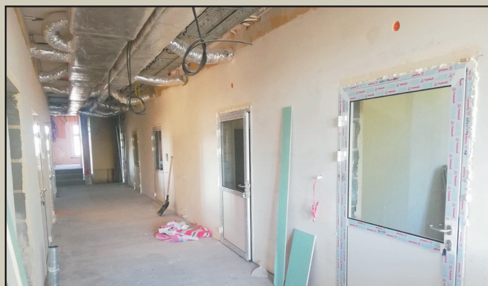
Montaż drzwi do sal
