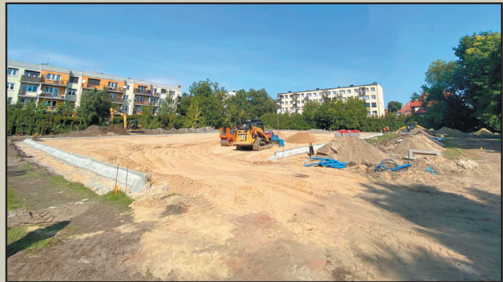
Przygotowanie podłoża przed położeniem sztucznej trawy
