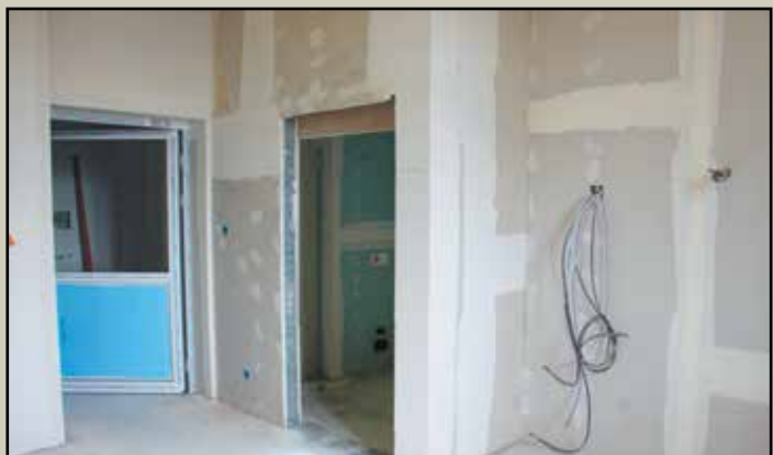
Przygotowanie ścian do gipsowania
