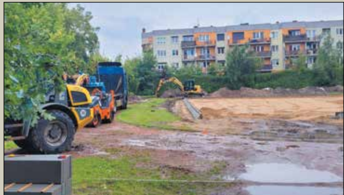
Przygotowanie podłoża pod sztuczną trawę
