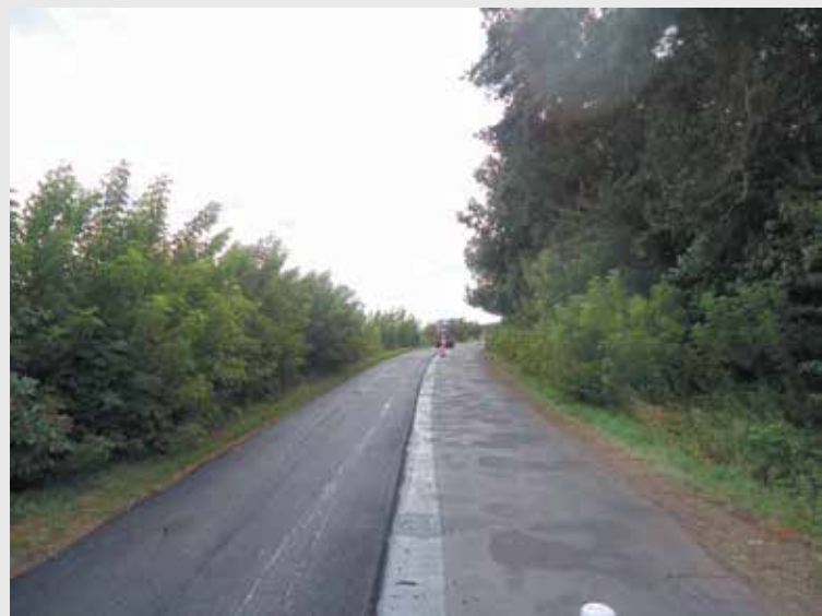
W trakcie modernizacji drogi między Sokolnikami a Szamarzewem
