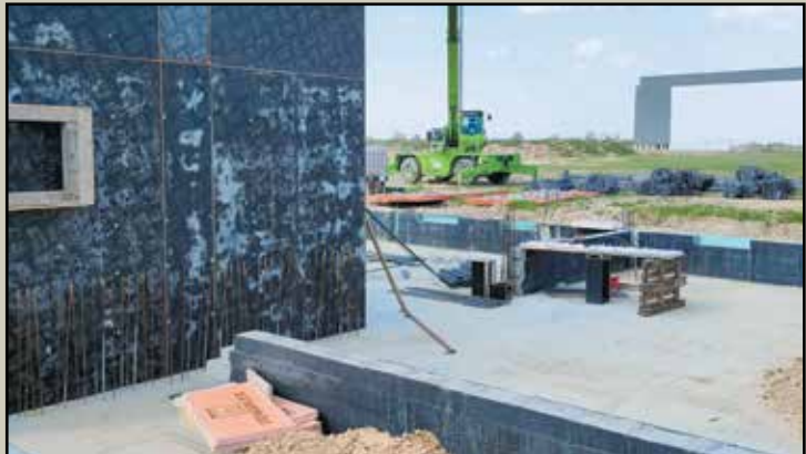
Wykonanie konstrukcji żelbetonowych parteru
