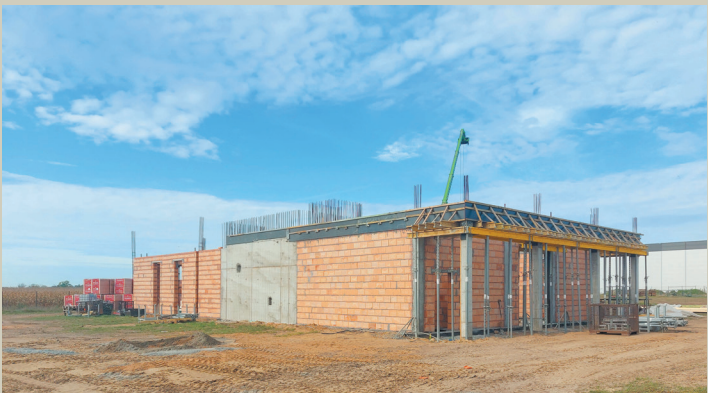
Murowanie ścian
