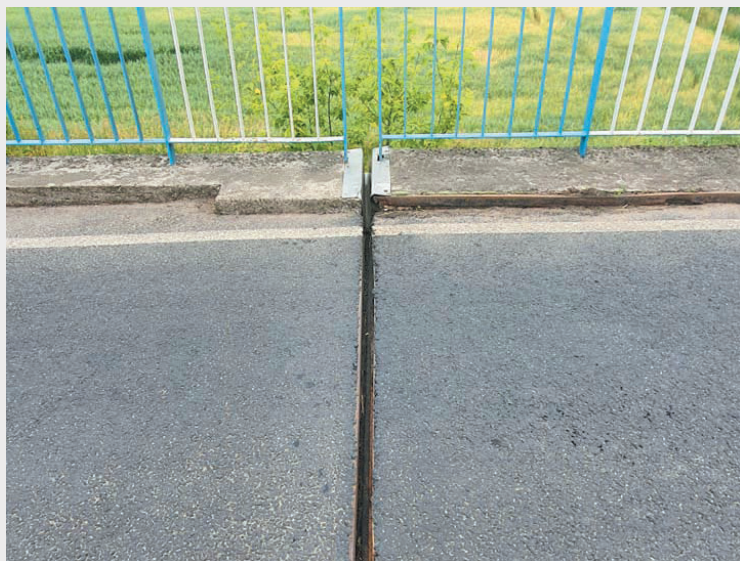
Prace obejmują m.in. oczyszczanie oraz naprawę dylatacji
