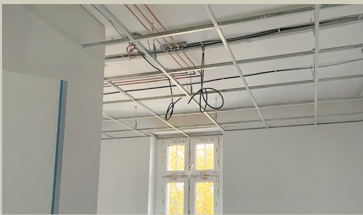
Montaż profili pod podwieszany sufit
