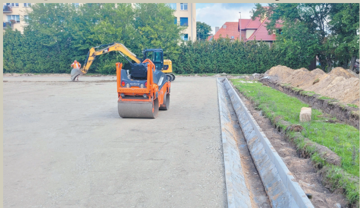
Przygotowanie podłoża pod bieżnię
