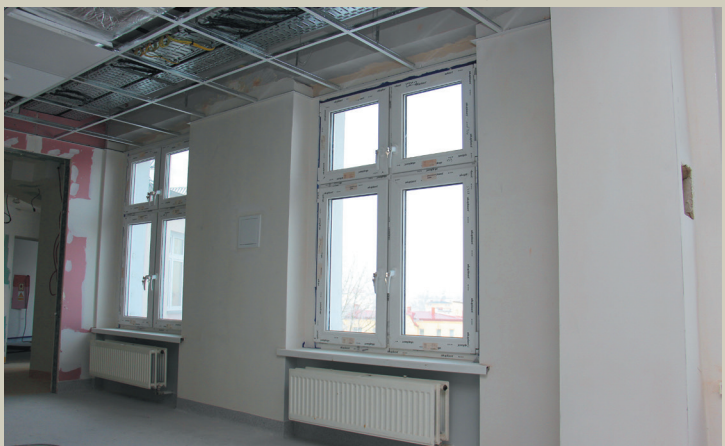
Postępujące prace przy wykańczaniu wnętrza nowego oddziału
