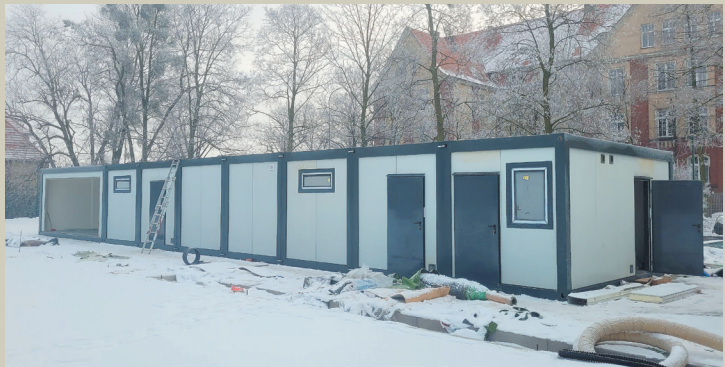
Montaż paneli ogrodzeniowych oraz dostawa i wyposażenie kontenerów
