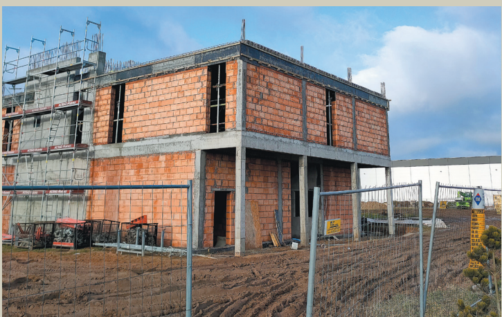
Roboty żelbetowe i murowe związane z konstrukcją piętra budynku
