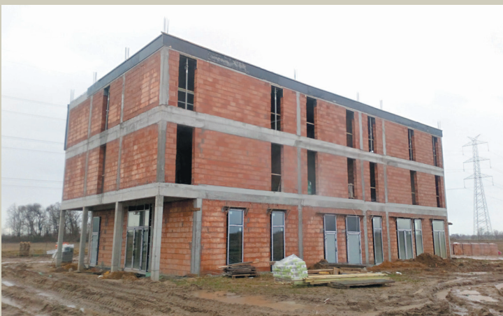
Montaż stolarki zewnętrznej
