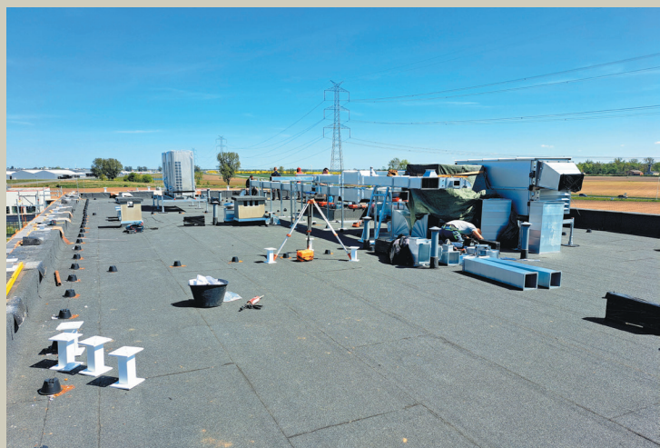
Montaż centrali wentylacyjnej i jednostek zewnętrznych do klimatyzacji
