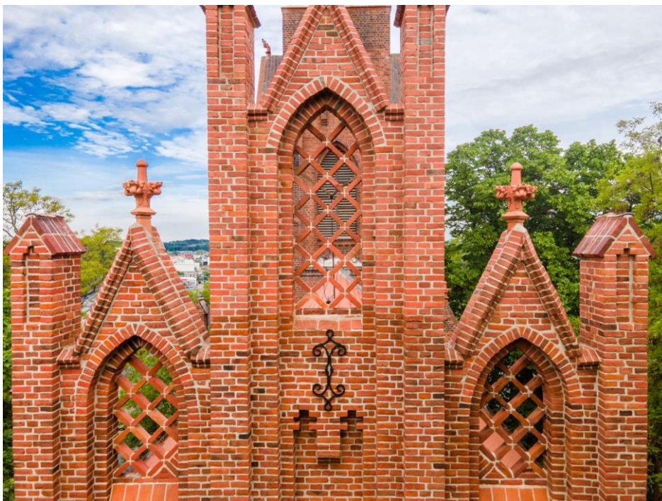
Odbudowana attyka kościoła ewangelickiego w Miłosławiu
