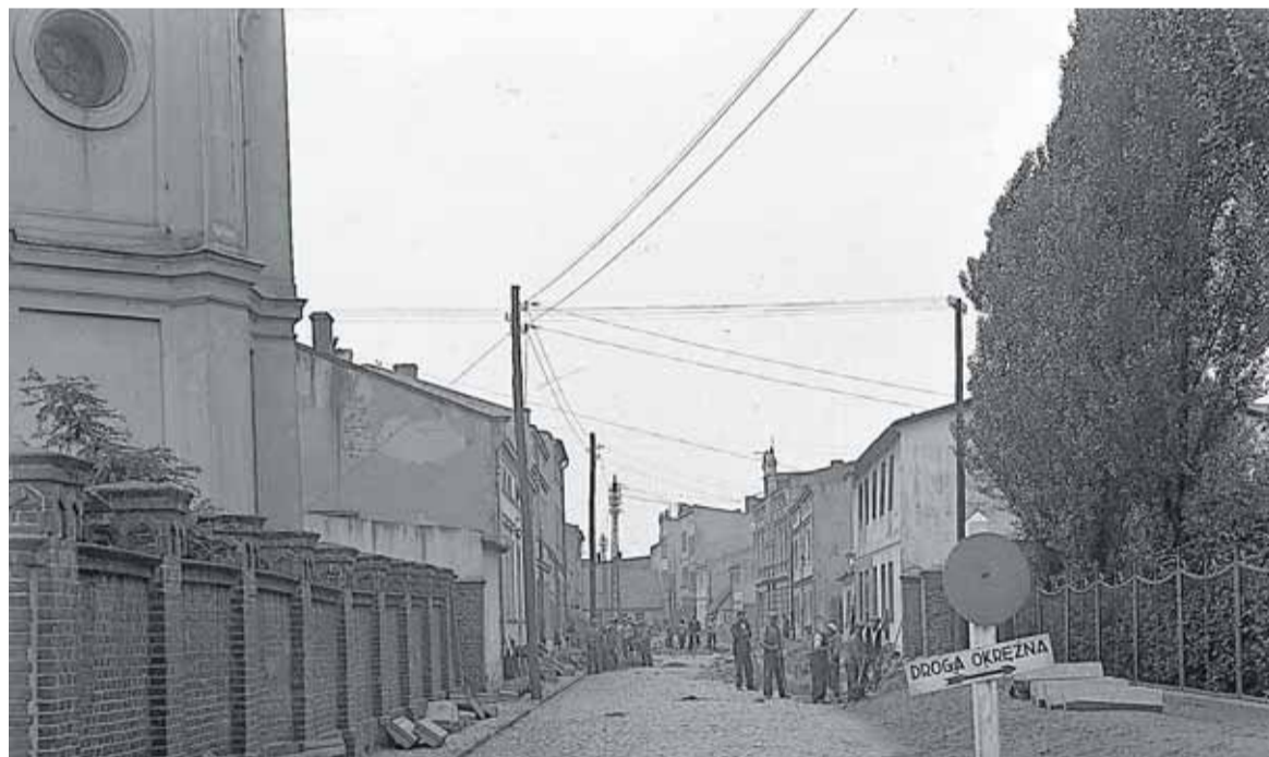
To samo miejsce widziane od ulicy Fabrycznej, róg Ratuszowej: po lewej absyda otoczona parkanem synagogi, dalej niski budynek rzeźni (w czasie wykonania fotografii już prawdopodobnie nie pełniący zgodnej z przeznaczeniem roli) i żydowski dom mieszkalny, dziś Cafe Balu (fot. Fr. Włosik, około 1938 r.)
