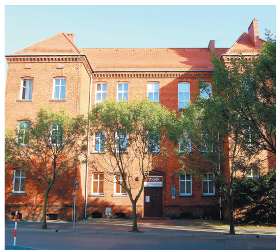
Budynek dawnego więzienia
