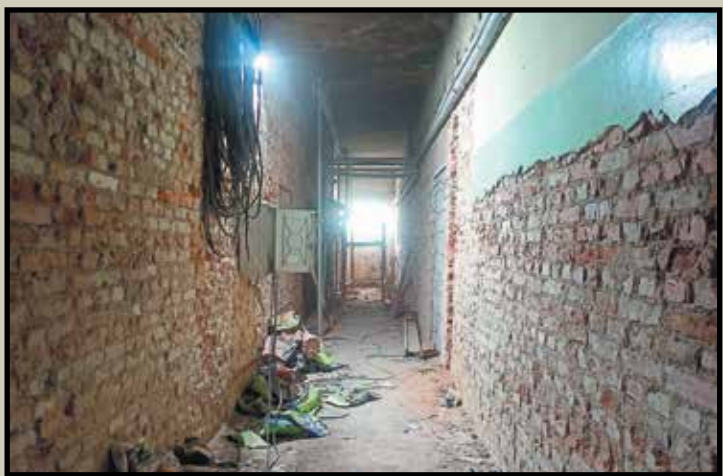
Rozbiórki istniejących warstw wykończeniowych podłóg oraz usuwanie tynków wewnętrznych
