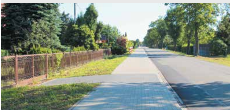
W Gutowie Małym mieszkańcy już korzystają z nowego chodnika
