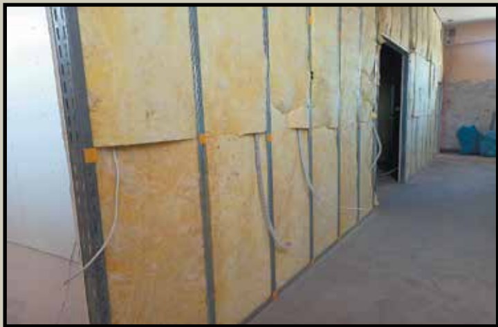
Wykonywanie ścianek działowych oraz instalacji elektrycznej
