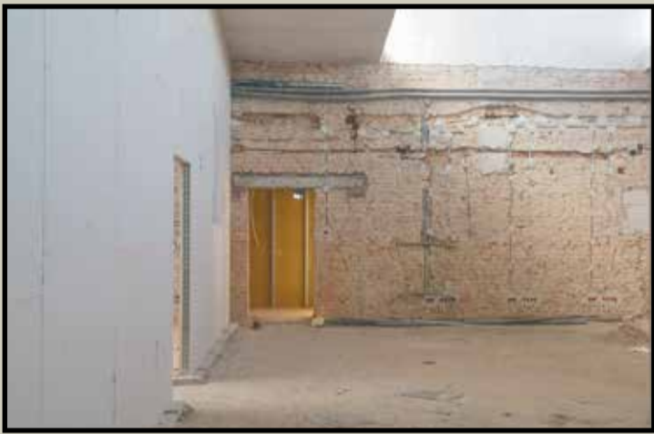
Roboty ogólnobudowlane oraz instalacyjne: sanitarne i elektryczne
