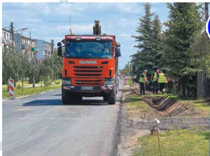
W zeszłym roku do przeprowadzania remontów Wydział Dróg Powiatowych zużył 490 ton kruszywa
