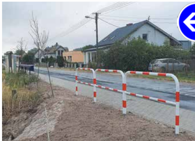
Takie umiejscowienie barier, choć często budzi zdziwienie, chroni użytkowników np. przed stromym spadem
