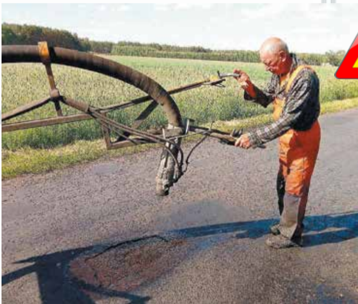
Przy sprzyjającej pogodzie remonty cząstkowe z wykorzystaniem emulsji i gryków są przeprowadzane przez cały rok. W 2019 roku zakupiono 60 ton emulsji
