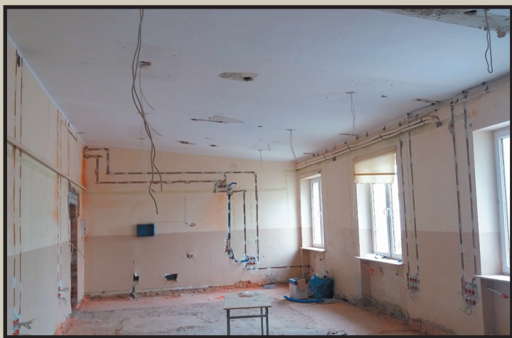
Montaż instalacji elektrycznych
