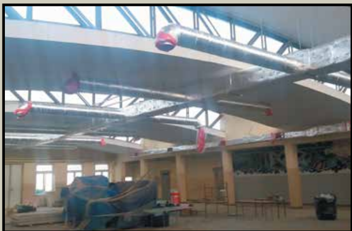
Prace budowlane oraz montaż instalacji elektrycznej i klimatyzacji
