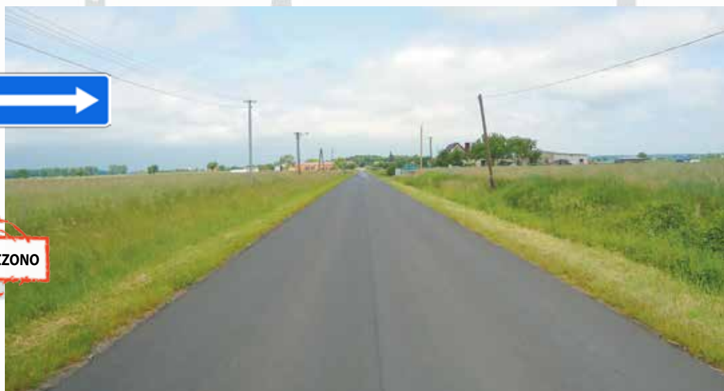
Inwestycja stanowiła kontynuację zadania z 2018 roku, kiedy to przebudowano 1,5 km drogi za kwotę 500 tys. zł
