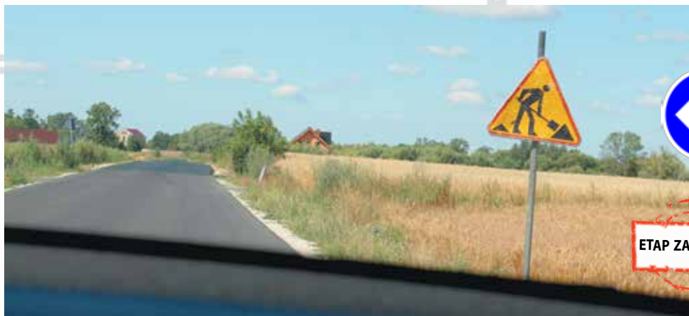
Jezdnię poszerzono o 1,2 m
