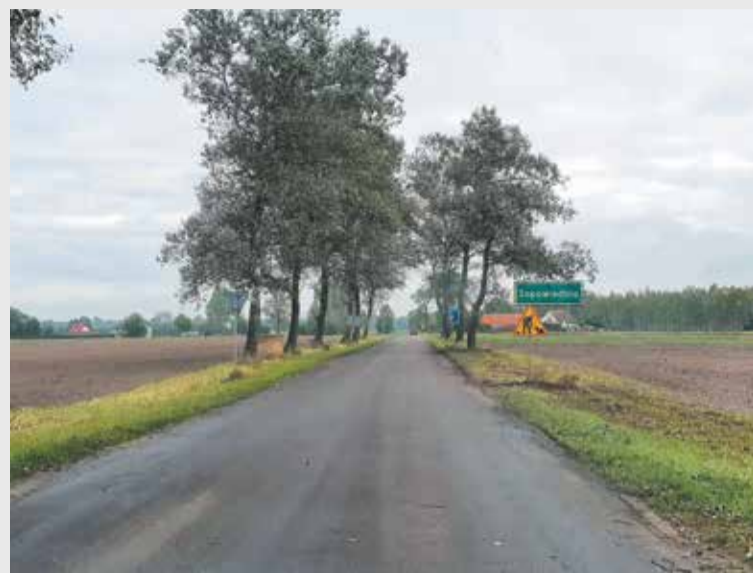
Przebudowa w Zapowiedni dotyczy 2,5-kilometrowego odcinka
