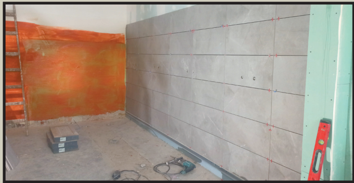
Trwa malowanie ścian, zakładanie płytek oraz montaż instalacji grzewczej
