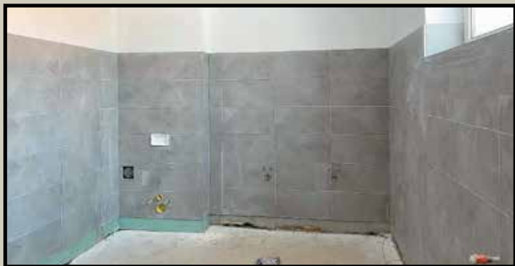
Trwa malowanie ścian, zakładanie płytek oraz montaż oświetlenia
