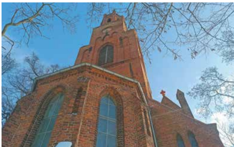
Prace obejmują remont wieży i rekonstrukcję attyki
