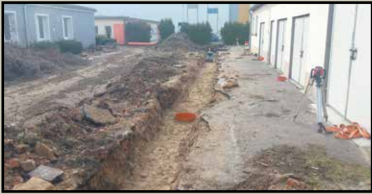
Trwa podłączanie instalacji sanitarnych
